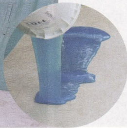
CBIポリマーズの「デコンジェル」を使った除染の様子。福島県内の幼稚園で実施し効果を上げた
