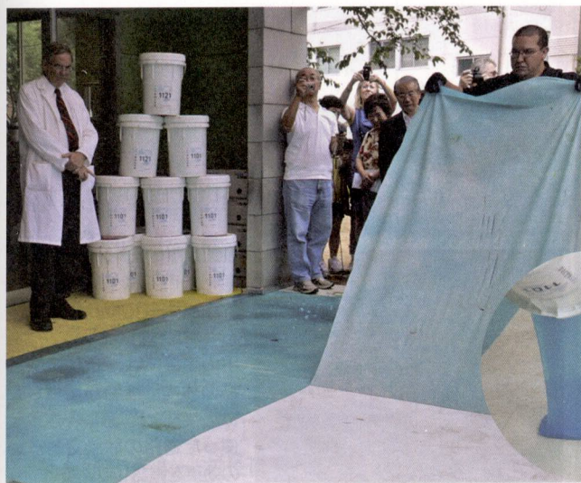
CBIポリマーズの「デコンジェル」を使った除染の様子。福島県内の幼稚園で実施し効果を上げた
